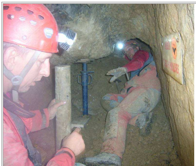
Etançonnement au Four à Chaud
